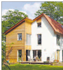
Passivhaus halb-halb: Ein reiner Holzbau verbessert die Klimabilanz erheblich
