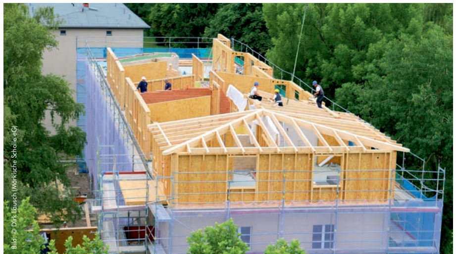
8 | Die Aufstockung der Gebäude erfolgt in Holzbauweise.
