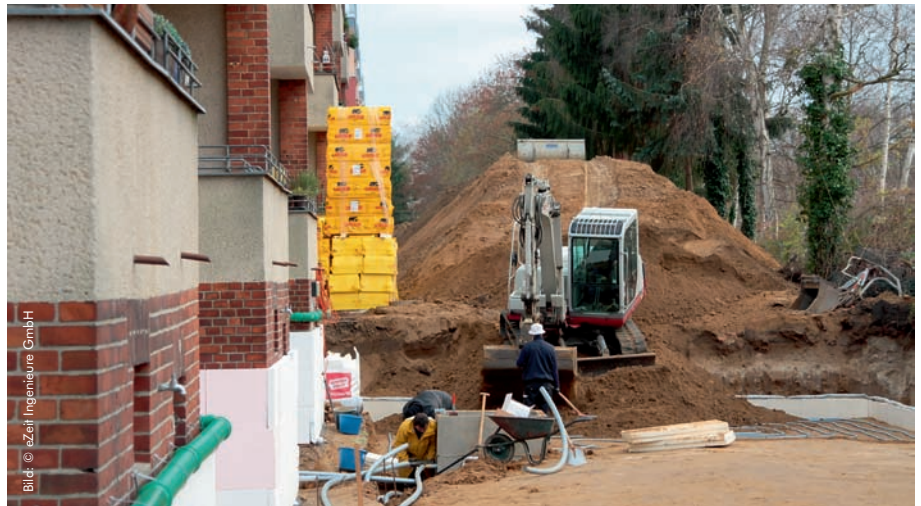
7 | An vier Gebäuden werden unterschiedliche WDV-Systeme angebracht.
