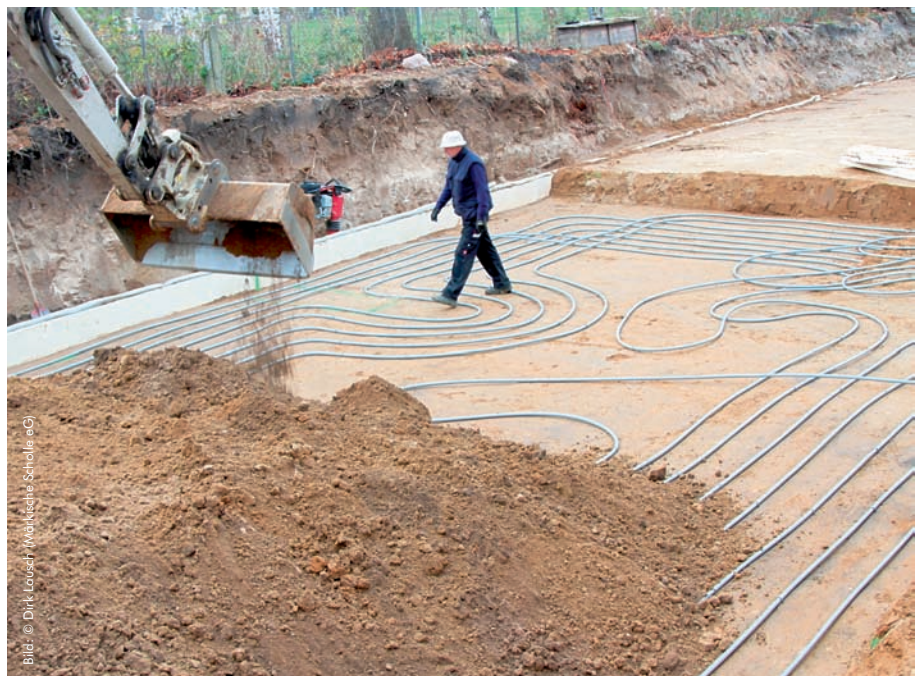
5 | Verlegung der Polyethylen-Leitungen für den eTank
