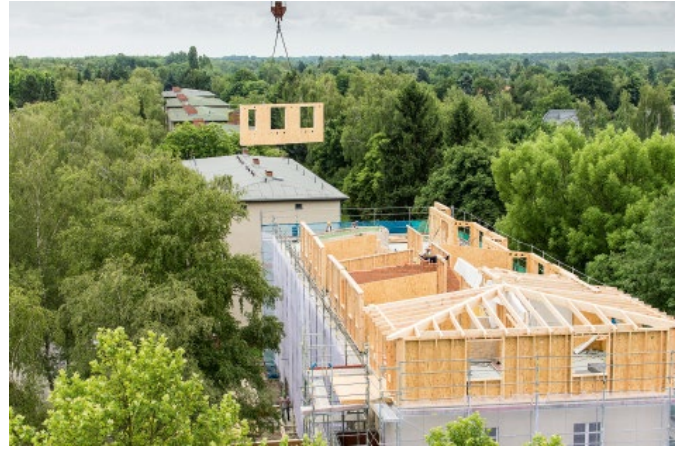
Bild 3. Umbau des Dachgeschosses in Holzrahmenbauweise zu familiengerechten Wohnungen (Fotos 1 und 3: Sergey Kleptcha)
