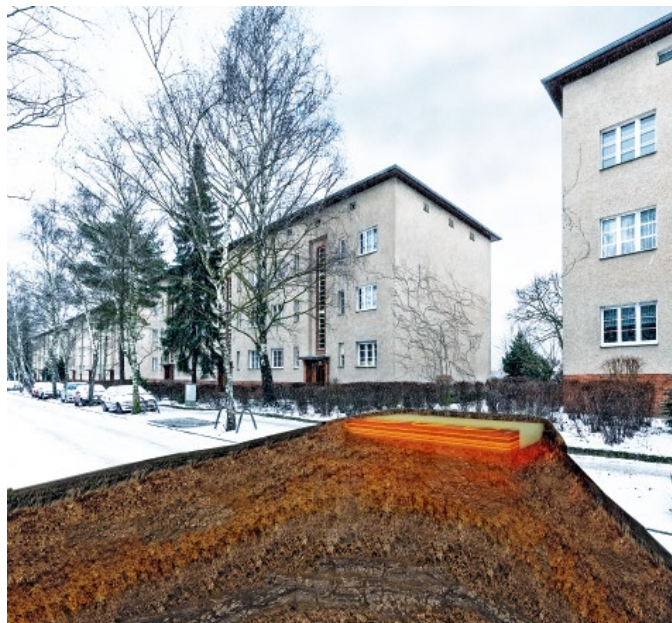
Bild 5. 1930er-Jahre-Bau mit Animation des eTanks
