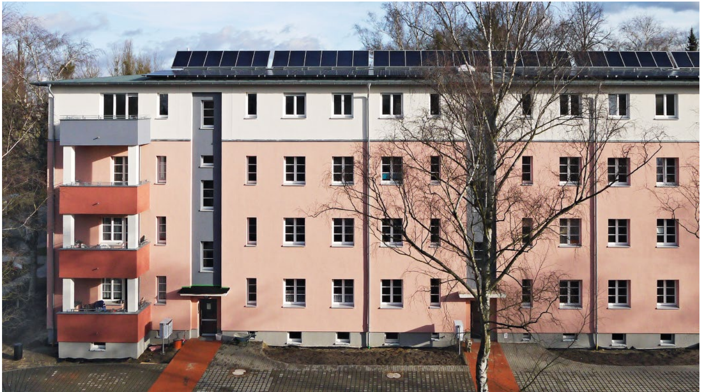
Bild 1. Saniertes 1930er-Jahre-Gebäude mit PV- und thermischer Solaranlage in der Wohnanlage Berlin-Lichterfelde Süd
