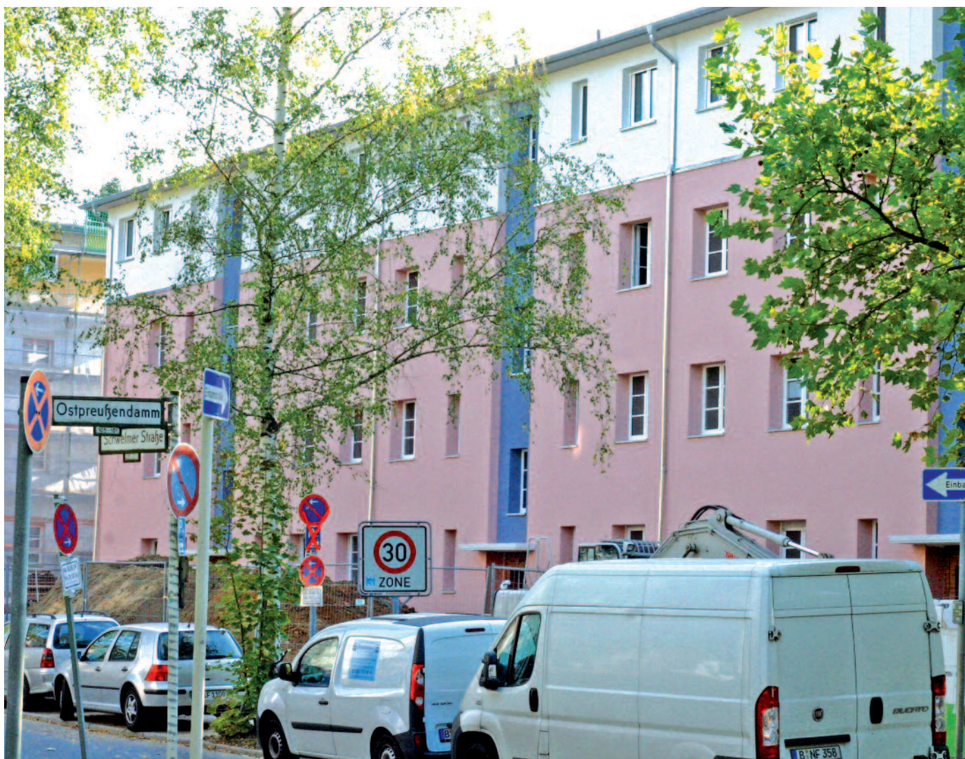
Zusätzliche Dachgeschosse auf den 30er-Jahre-Bauten schaffen neuen Wohnraum.
