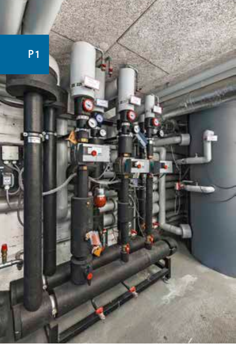
▲ Vorlauf und Rücklauf der Heizung und des Ladeheizkreises
