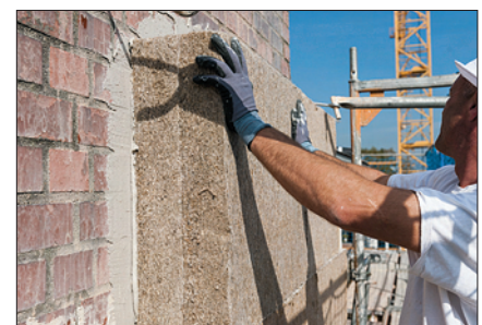
... dann werden die Hanfplatten des Dämmsystems stumpf stoßend am Wandbildner fixiert ...
