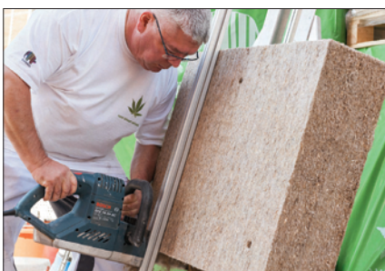
Hanfplatten des Fassadendämmsystems Capatect Natur+ lassen sich vor Ort maßgenau zuschneiden.
